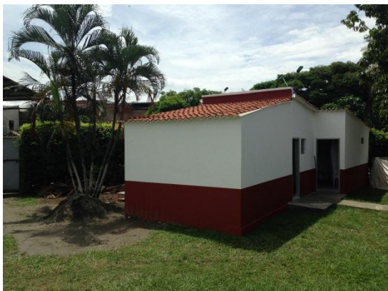
Construcción comodatario Plazas Verdes
