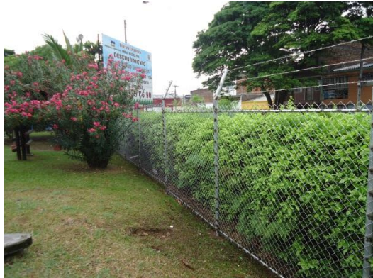
Encerramiento en malla Descubrimiento
