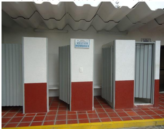
Remodelacion vestiers Rincón Pacara
